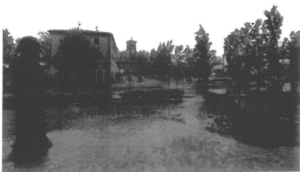
Le foto evidenziano il fenomeno di ristagno delle acque meteoriche in corrispondenza delle aree esterne alla Casa Natale. Gran parte del degrado dell'edificio si lega infatti ai fenomeni di risalita dell'umidità dal terreno.
