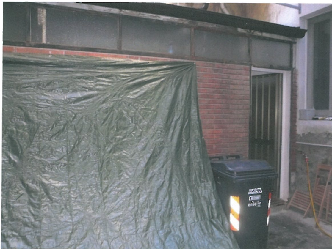
Blocco servizi nel cortile
