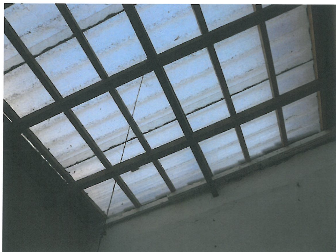
Copertura del cavedio nell'appartamento
