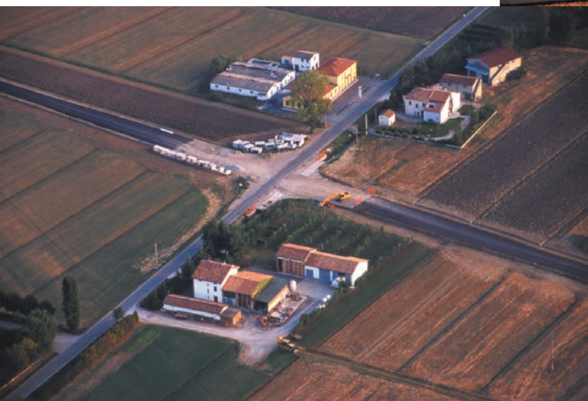
Lavori tangenziale di Busseto
